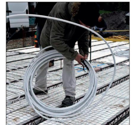
**3** MISE EN PLACE DES TUBES UPONOR SUIVANT PLAN DE POSE
